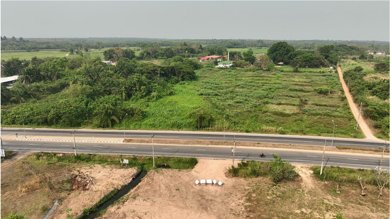
รูปที่ 5-8 ช่วง กม.5+319 จุดตัดกับทางหลวงหมายเลข 1157 บริเวณ กม.2+275 (พื้นที่ก่อสร้างถนนสายแยก ทล.11 ถึง ทล.1 อ.เมือง จ.ลำปาง ตอนที่ 1 อยู่ระหว่างดำเนินการก่อสร้าง)
