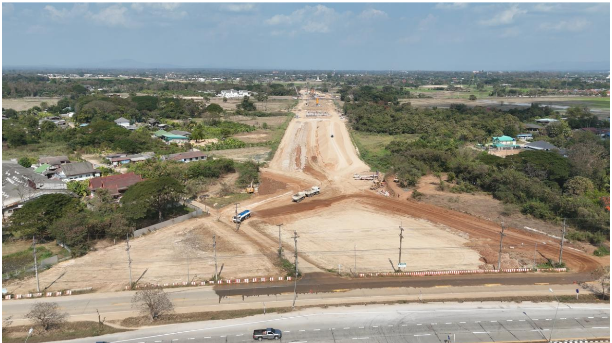
รูปที่ 5-1 จุดเริ่มต้นโครงการตอนที่ 1 บริเวณจุดตัดทางหลวงหมายเลข 11 (กม.0+000)
