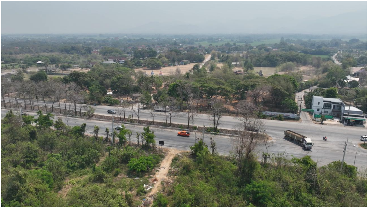
รูปที่ 5-18 จุดสิ้นสุดโครงการ กม.13+353 บริเวณโครงสร้างต่างระดับจุดตัดทางหลวงหมายเลข 1 (แนวถนนสายแยก ทล.11 ถึง ทล.1 อ.เมือง จ.ลำปาง ตอนที่ 2)
