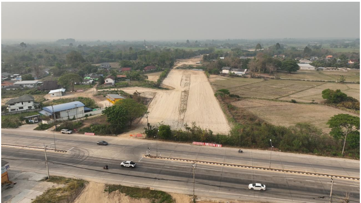
รูปที่ 5-5 ช่วง กม.2+930 จุดตัดกับทางหลวงหมายเลข 1039 บริเวณ กม.6+269 (พื้นที่ก่อสร้างถนนสายแยก ทล.11 ถึง ทล.1 อ.เมือง จ.ลำปาง ตอนที่ 1 อยู่ระหว่างดำเนินการก่อสร้าง)
