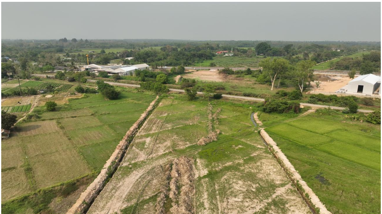
รูปที่ 5-7 ช่วง กม.5+000 (พื้นที่ก่อสร้างถนนสายแยก ทล.11 ถึง ทล.1 อ.เมือง จ.ลำปาง ตอนที่ 1 อยู่ระหว่างดำเนินการก่อสร้าง)
