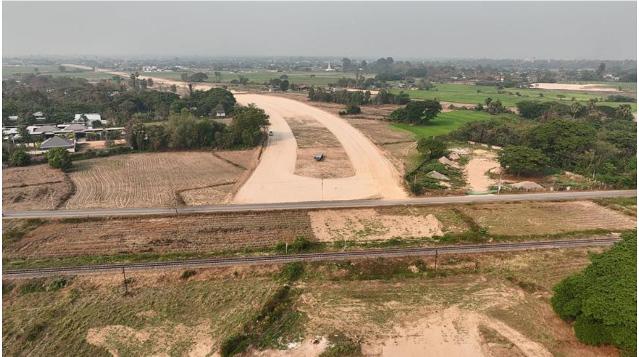
รูปที่ 5-2 ช่วง กม.0+687 จุดตัดกับทางรถไฟ (พื้นที่ก่อสร้างถนนสายแยก ทล.11 ถึง ทล.1 อ.เมือง จ.ลำปาง ตอนที่ 1 อยู่ระหว่างดำเนินการก่อสร้าง)
