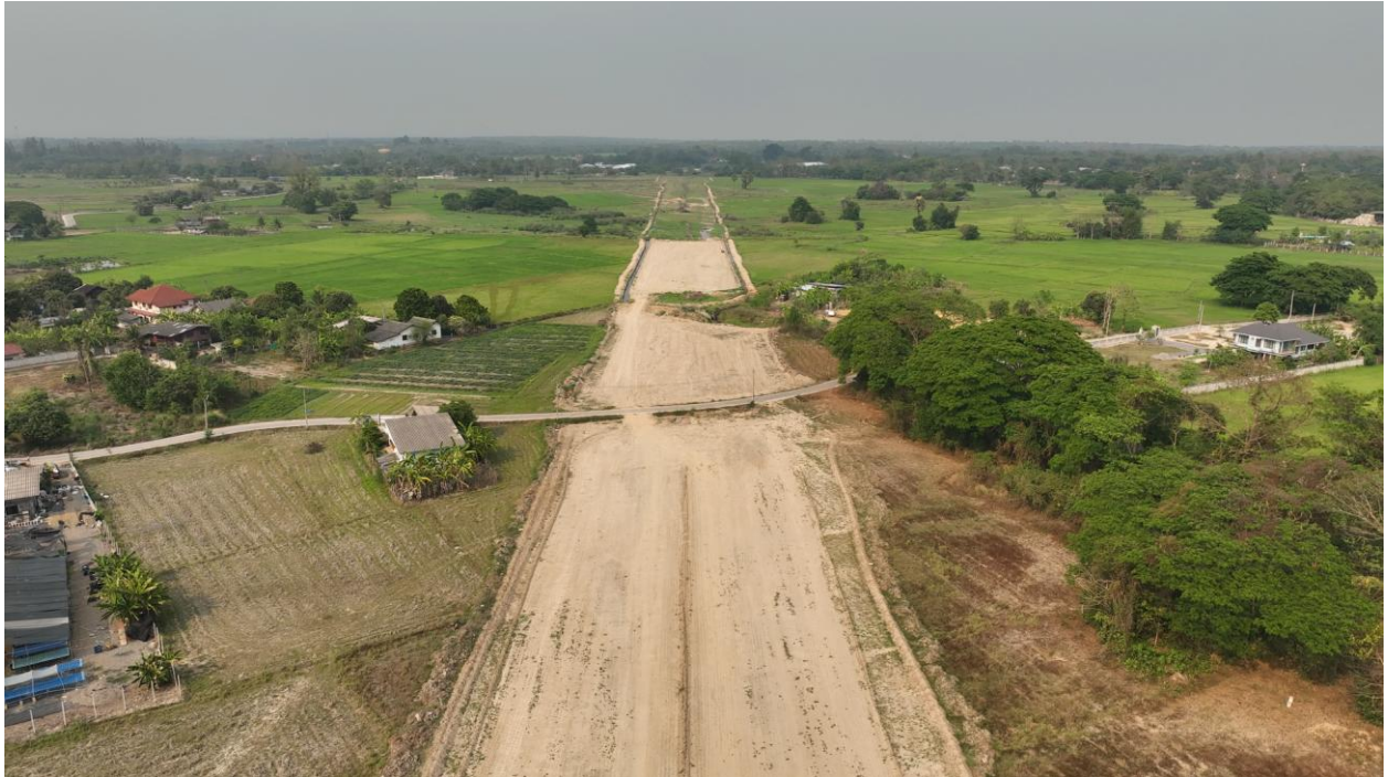
รูปที่ 5-6 ช่วง กม.4+000 (พื้นที่ก่อสร้างถนนสายแยก ทล.11 ถึง ทล.1 อ.เมือง จ.ลำปาง ตอนที่ 1 อยู่ระหว่างดำเนินการก่อสร้าง)
